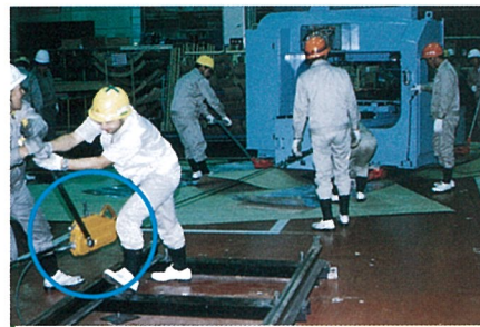
工作機械・各種設備・重量物等の移動・据付作業 (TU-16)
