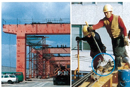
橋梁の横移動工事 (横取り工法) (T-35)
