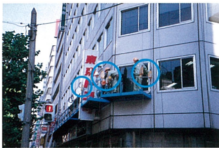
養生足場・仮設足場昇降作業 (T-7)
