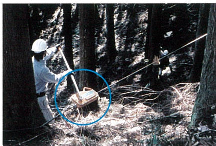
木材の伐採・方向決め作業 (TU-16)
