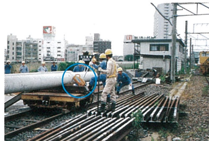
電柱の荷締・荷降し作業 (TU-16) NEWS 0209
