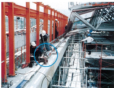
大型屋根の横引き (スライド工法) (T-35) 吊り上げ (リフトアップ工法) (T-35)
