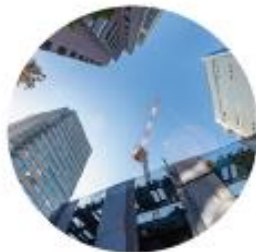
上空視界の狭い 都市部工事
